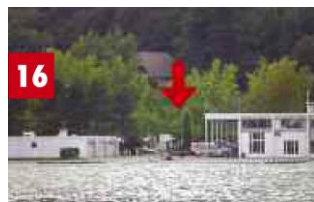
Le centre nautique des Marquissats
