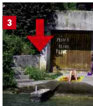
Mise à l'eau — ponton béton
