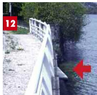
Mise à l'eau — escalier au sud de l'hôtel
