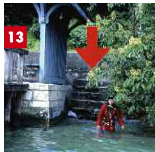
Mise à l'eau — escalier de l'embarcadère
