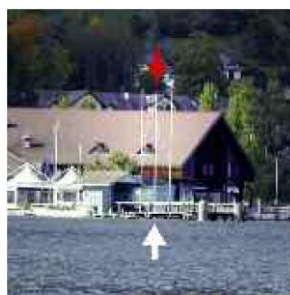
AMER B — mât du milieu du slip-way
