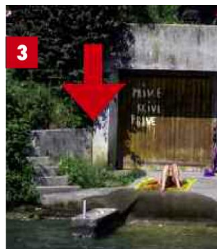
Mise à l'eau — ponton béton
